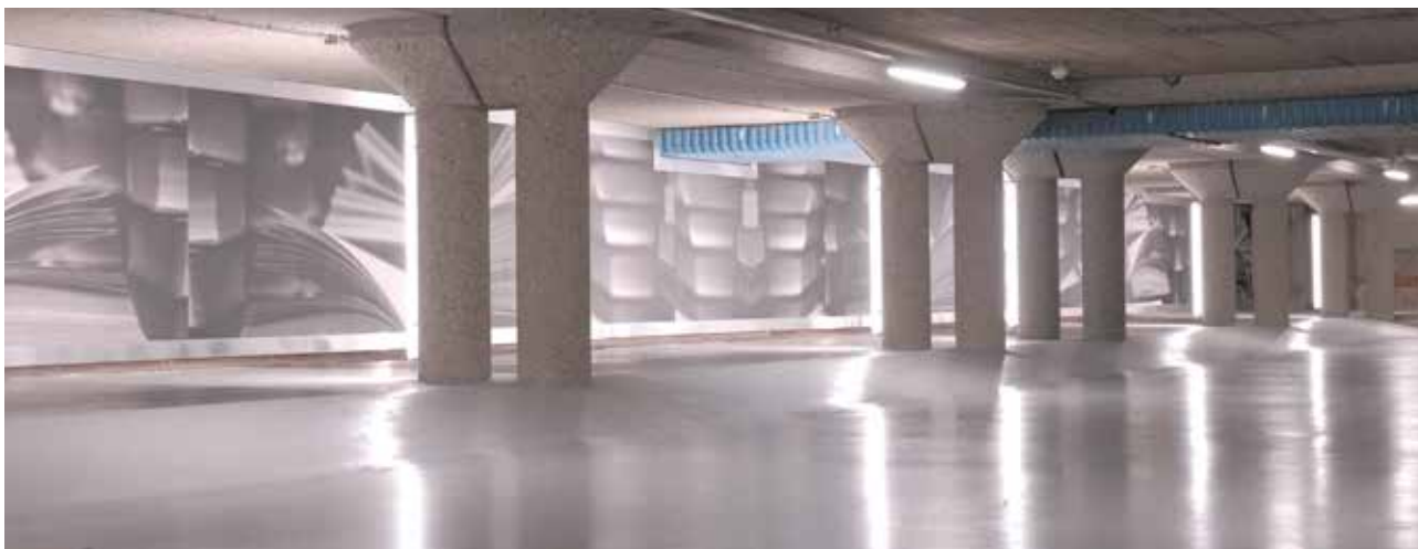
Parkeergarage Maliebaan, Leiden
